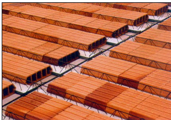
Figura 82 – Nervura transversal (FAULIM, 1998).
