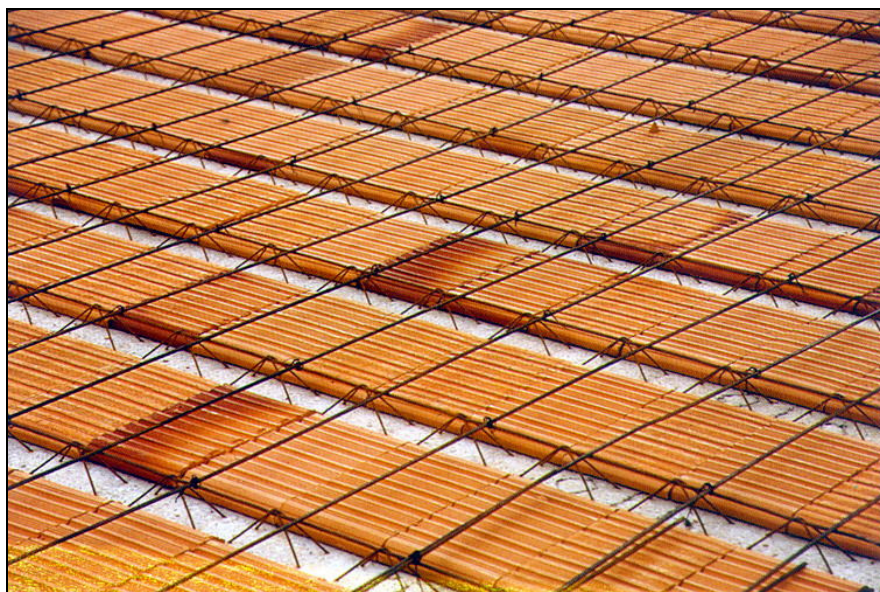
Figura 77 – Laje pré-fabricada do tipo treliçada (FAULIM, 1998).
