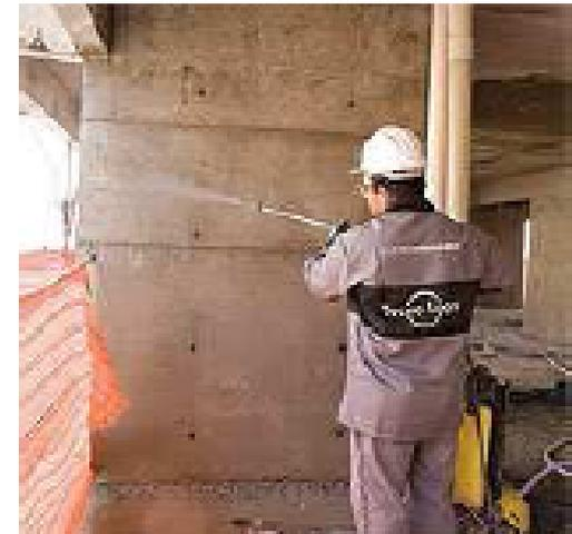
3. Chapisco do concreto que ficará em contato com a alvenaria.
